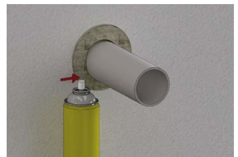
12. Fill up with PU foam
