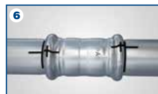
6 Marcare la giunzione completata
