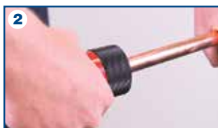
Sbavare esternamente il tubo
