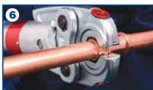
Allineamento delle ganasce al raccordo
