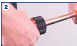
Sbavare esternamente il tubo
