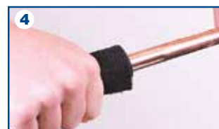
Pulire la superficie esterna del tubo
